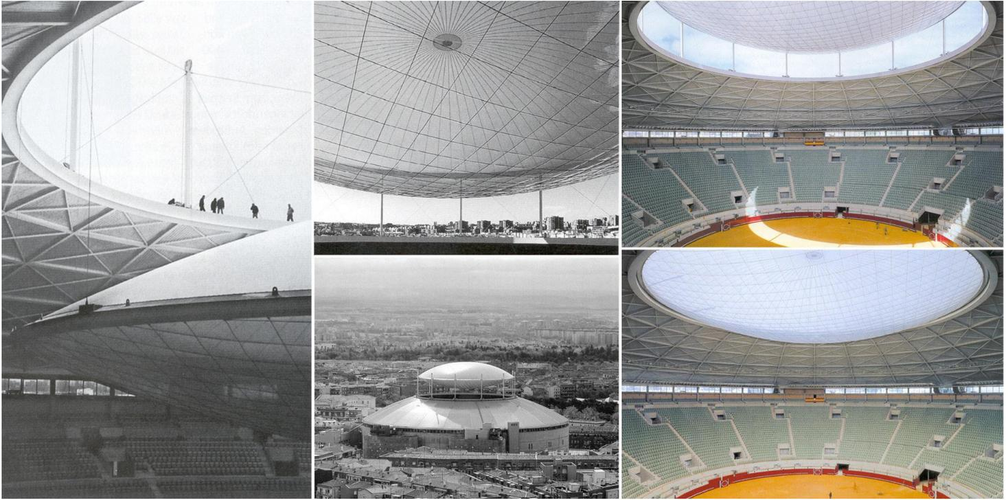
La cubierta fija del Centro Integrado Vista Alegre es una cúpula esférica tipo Schwelder. Está formada por paralelos, meridianos y diagonales de acero, con relación flecha/luz de 1/8, y se apoya en pilares de hormigón en su perímetro.
